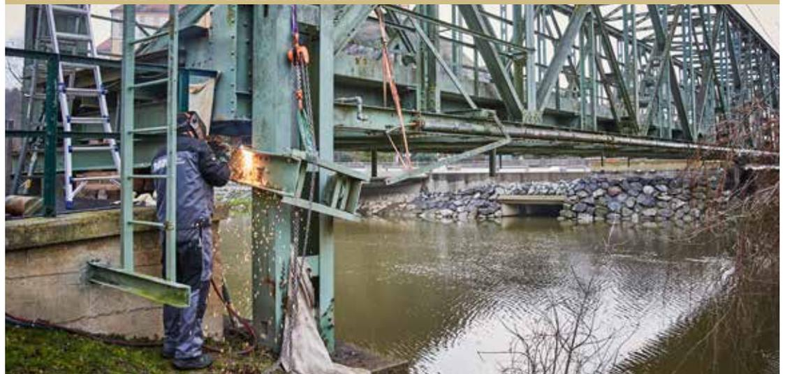
Mitarbeiter der Firma Metall Präzision Halbwachs aus Mank haben Anfang Dezember einen verbogenen Halterahmen an der Hubbrücke abgetrennt und erneuert. Der Rahmen hatte sich beim Anheben der Brücke bei einem Hochwasser im Juli 2021 verkeilt. Die Brücke wurde daraufhin in der angehobenen Position fixiert und mit Holzsteigen für Fußgänger passierbar gemacht. Jetzt ist die Brücke wieder frei passierbar für Fußgänger und Radfahrer. Foto: Franz Gleiß
