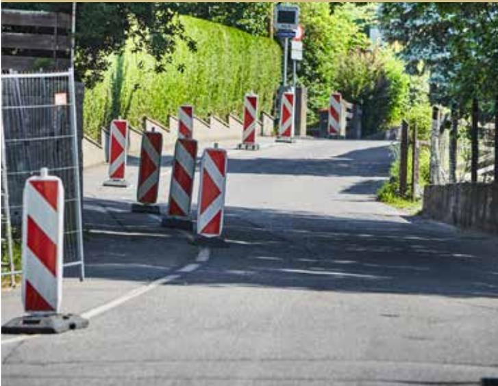
Der bereits bestehende Gehsteig im oberen Bereich der Fürnbergstraße wird in Richtung Süden bis zur Abt Amand John-Straße verlängert. Der neue Gehsteig wird im Bereich der derzeit aufgestellten Baken (Foto) mit einer Breite von zwei Metern errichtet. Für die Fahrbahn bleiben vier Meter Breite. Die Arbeiten sind mit drei Wochen Dauer veranschlagt und werden vom Wirtschaftshof der Stadtgemeinde im Juni bzw. Juli durchgeführt. Foto: Franz Gleiß
