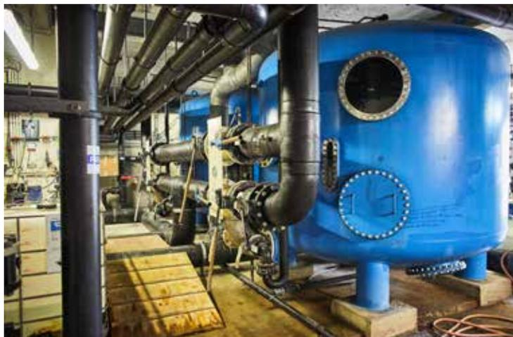
Das gesamte Wasser aller Becken wird durch vier mit Tonnen von Sand gefüllte Behälter gepumpt und gereinigt. Fotos: Franz Gleiß
