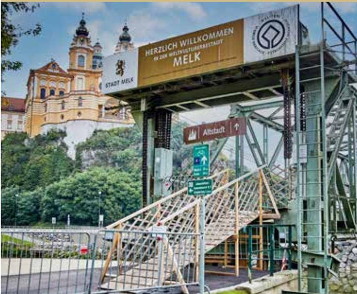
Beim Anheben der Hubbrücke wegen eines Hochwasser im Juli kam es zu einem technischen Defekt des Halterahmens am linken Ufer. Die Brücke wurde in dieser Höhe für Reparaturarbeiten gesichert. Eine Stahlbaufachfirma wird demnächst den Halterahmen austauschen. Die Hubbrücke ist in dieser Position sicher und stabil und für Fußgänger geöffnet. Foto: Franz Gleiß
